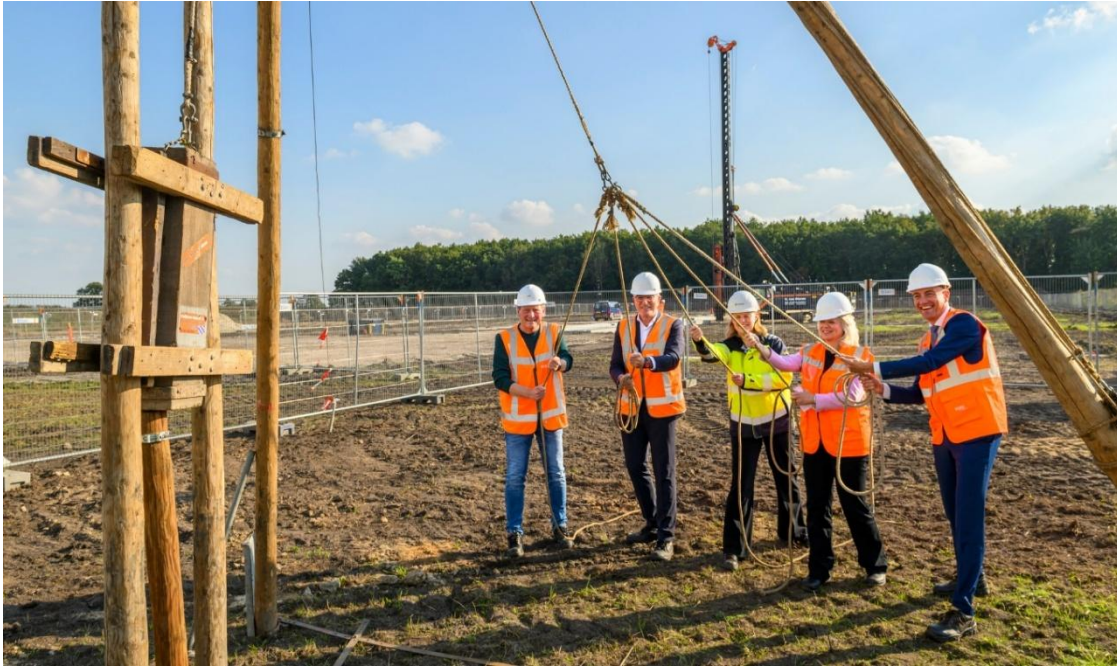
Start bouw nieuw hoogspanningsstation Hoogeveen
