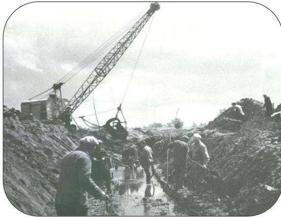
Kanalisatie van de Ruiten Aa (archief ws H&A)
