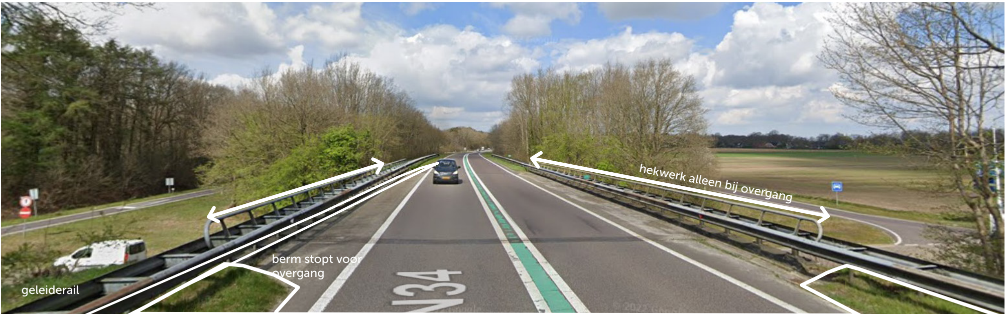
Onderdoorgang: verbinding kruist onder N34 door
