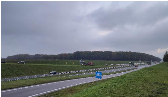
Figuur 3.1: Verkeer op afrit N33, oosttak knooppunt Gieten
