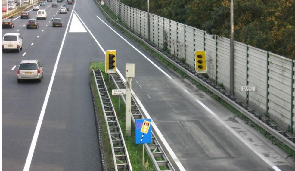
Figuur 4.1: Voorbeeld toeritdoseerinstallatie
