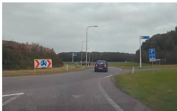
Afbeelding 6: Vervaagde markering rotonde Gieten
