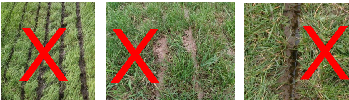
Figuur 2. Een slecht werkresultaat (buiten de sleuf, links (2a) & midden (2b)); besmeuring rechts (2c)).
