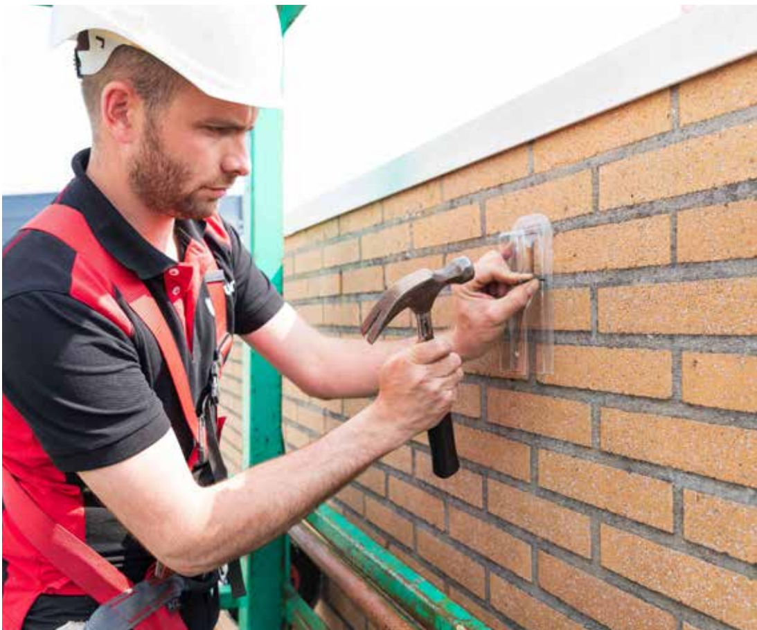
Plaatsen van een exclusion flap, om de woning natuurvrij te maken (Unitura.nl)
