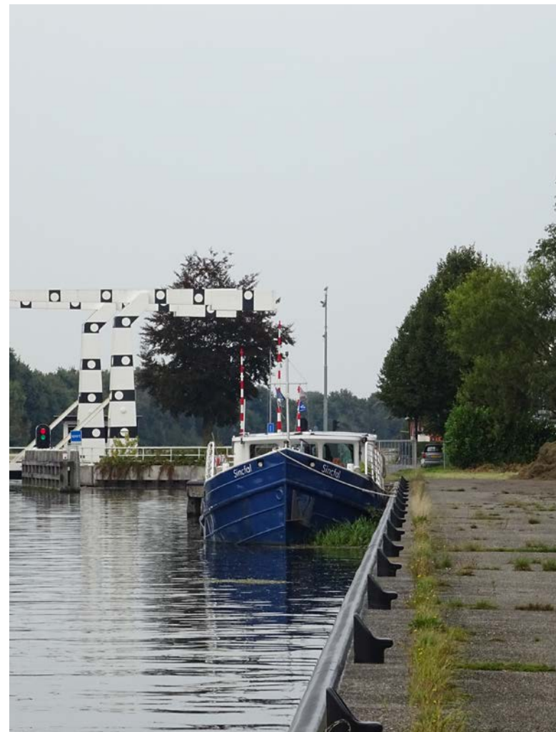
Brug Vriezerweg met zicht op de aanlegkade
