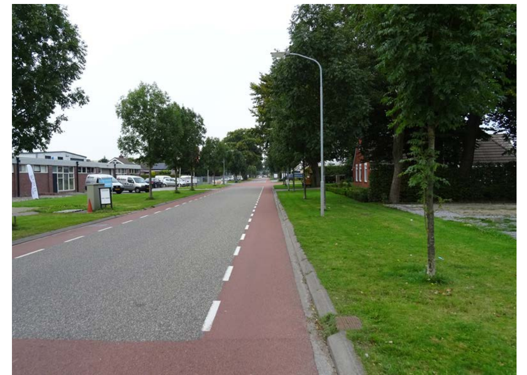
Fietspaden op de Meerweg door het industrieterrein
