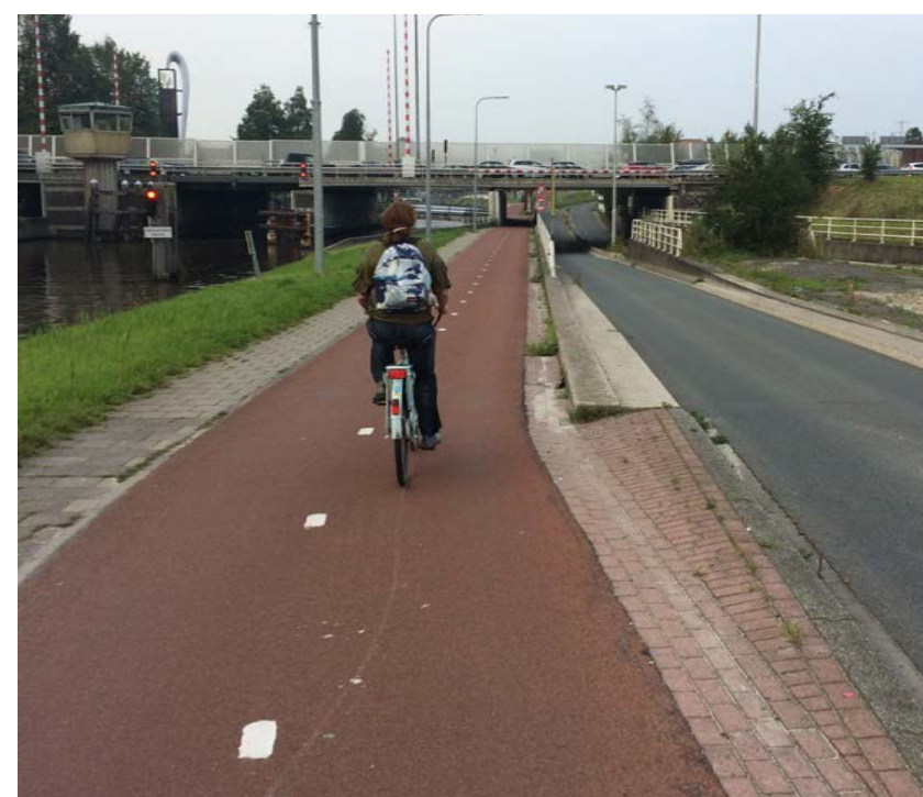
Kanaaldijk naast berm A28, onderdoorgang Ring Zuid
