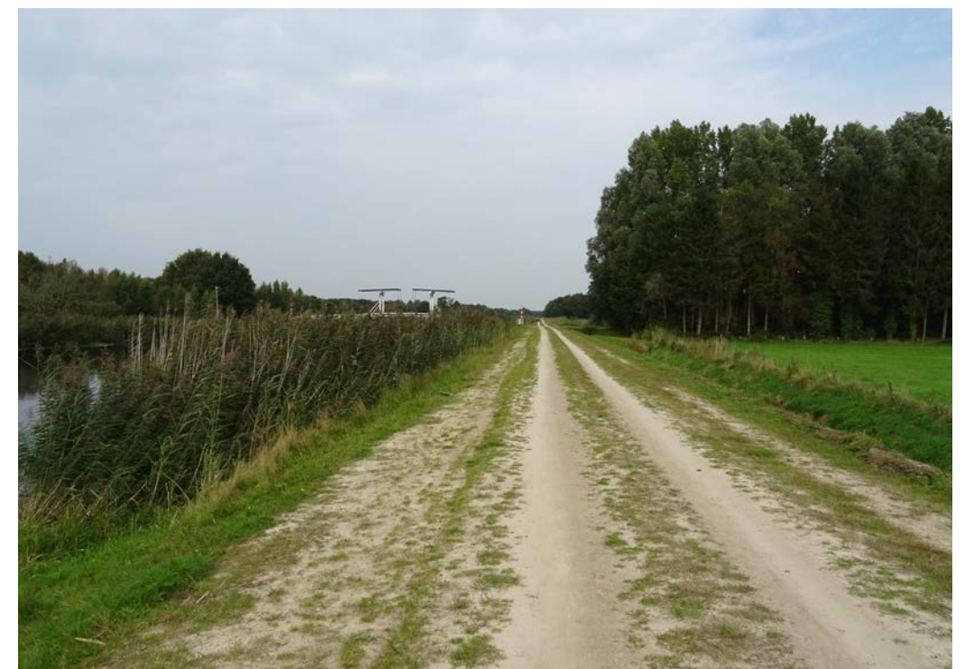
Wedstrijdsteigers langs het kanaal, oostzijde kanaaldijk met zicht op brug Enkeerdpad
