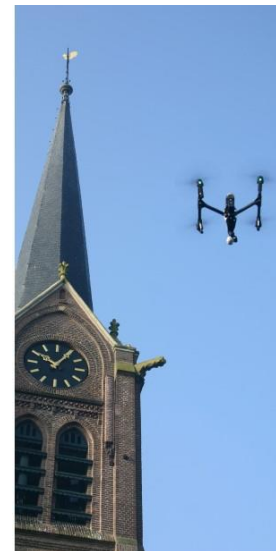
Inspectie door drones
