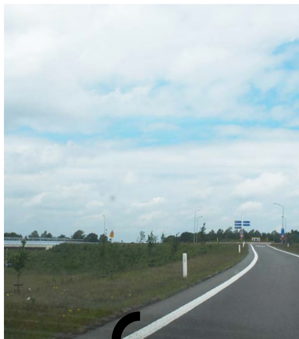
Voorbeeld van de nieuwe stijl op- en afritten.
