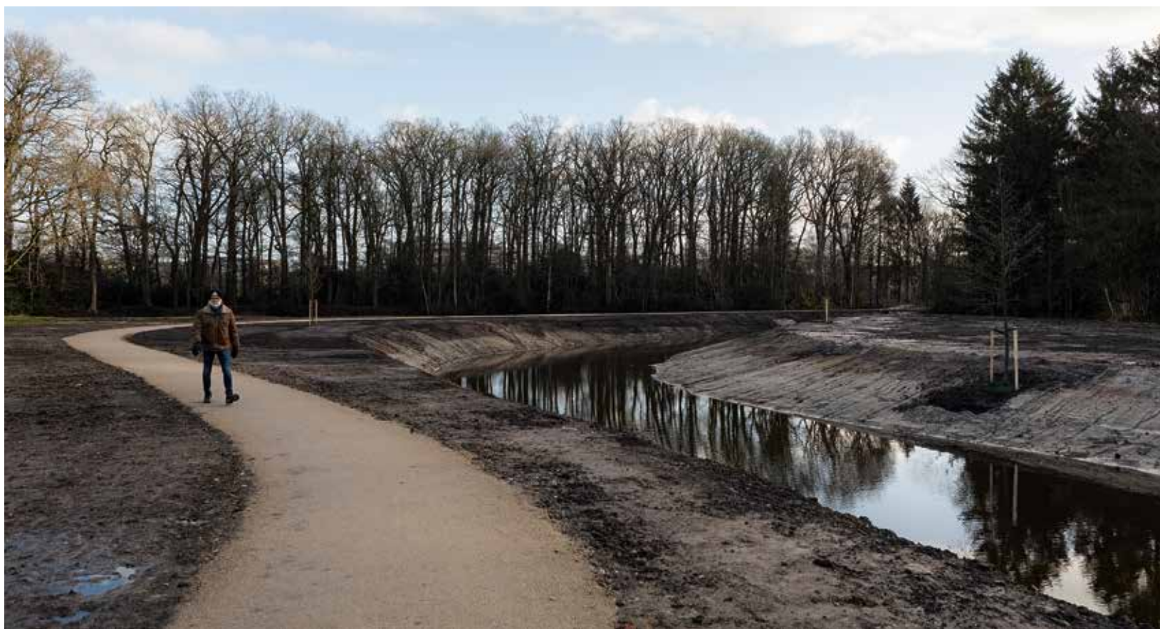
In het deel waar de oorspronkelijke beek onder een woonwijk doorloopt zijn nieuwe meanders gegraven.
