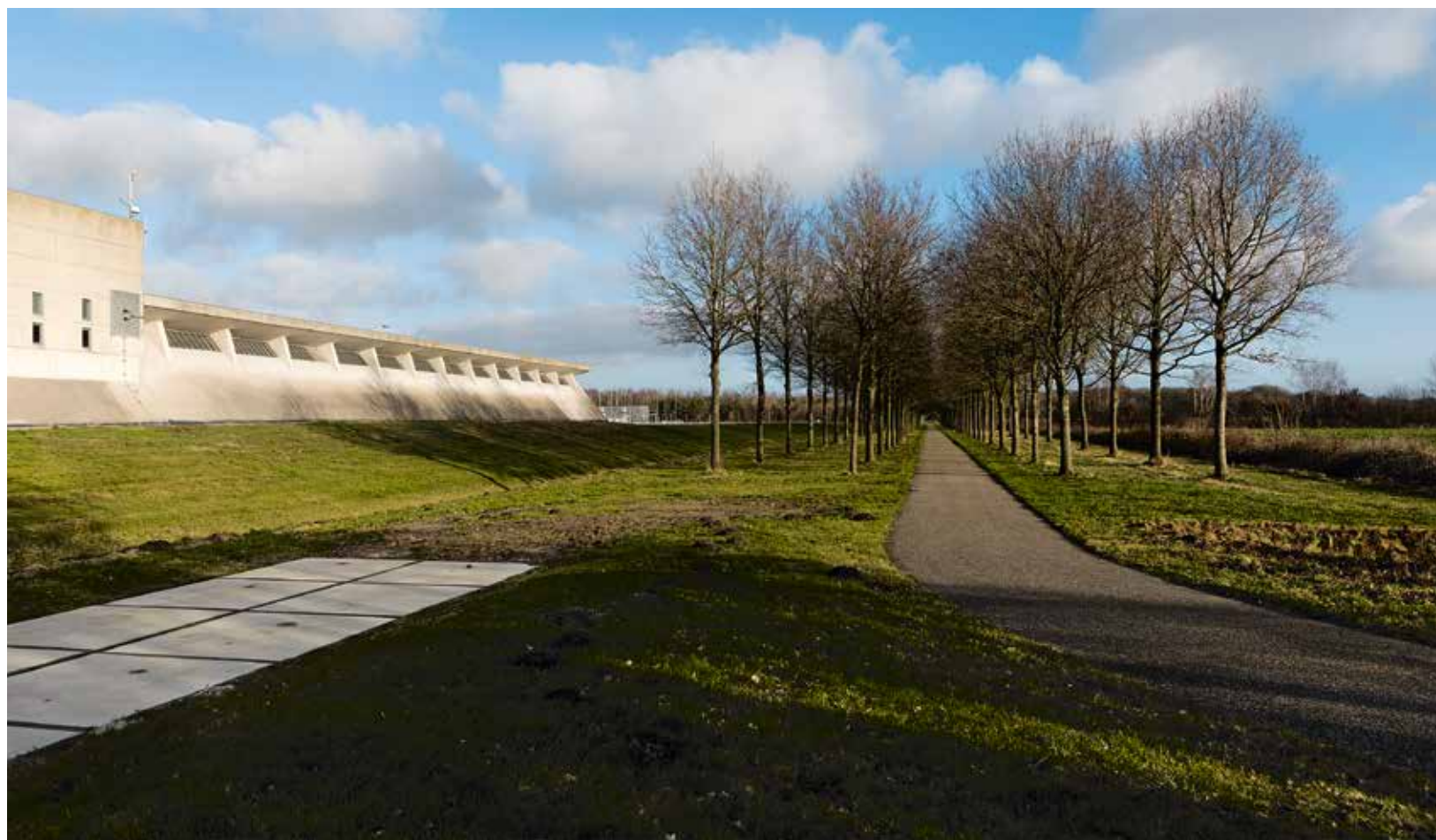
Naast het talud voor de plint van zilvergrijze betonnen gebouwen ligt een fietspad met een dubbele rij eiken.
