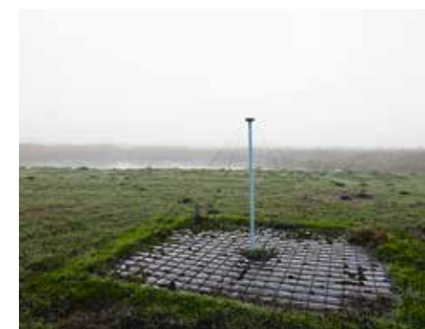
Bij Buinen staan twee typen telescopen. 48 zwarte dozen (voor hoge frequenties) en 96 'buitenantennes' – witte vlaggenmasten willekeurig in het grasland geplaatst.
