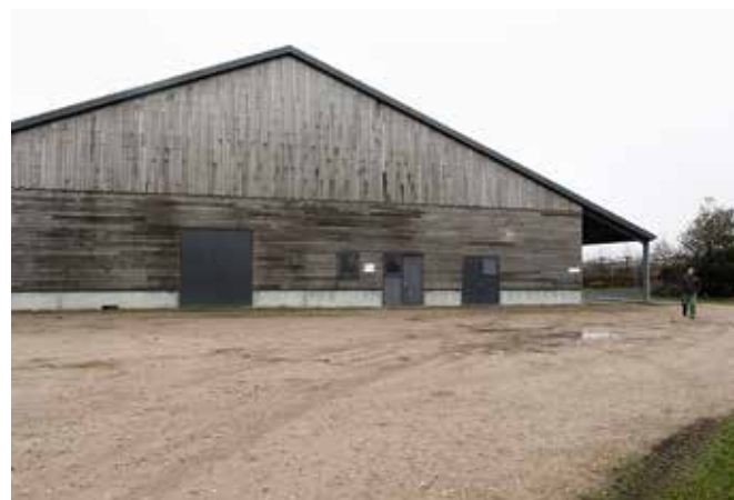
De gevel van de stal is bekleed met hout.
