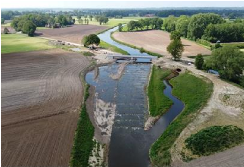
Afbeelding 7: Stuwsysteem 'War' na de ombouw tot een cascade-vistrap en hoogwatergeulen (Foto: Landkreis Graftschaft Bentheim).
