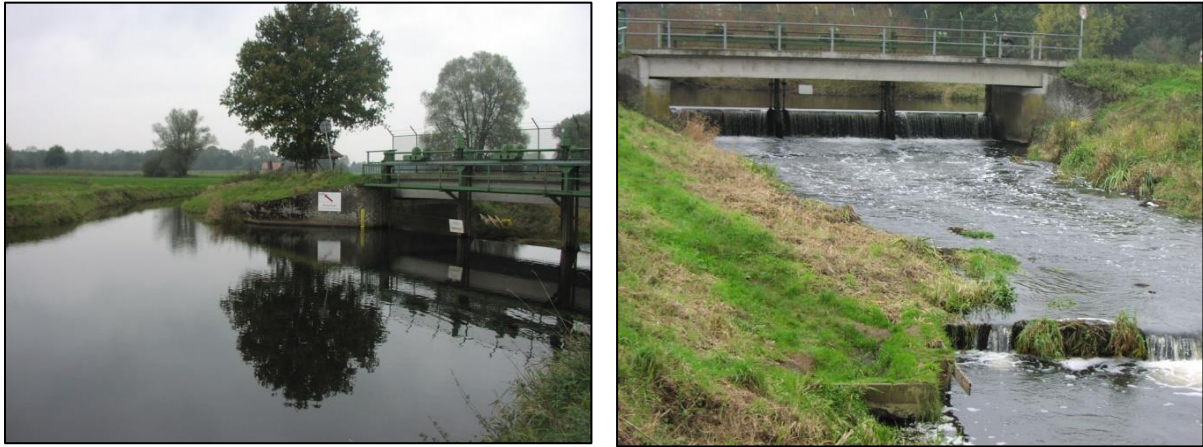
Afbeelding 5: Stuw „War“ in de Dinkel bij Lage voor de ombouw, links: bovenstrooms (foto Rathcke), rechts: benedenstroom (foto Landkreis Grafschaft Bentheim).
