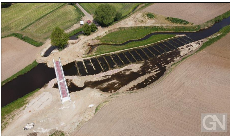
Abbildung 7: Wehranlage „War“ nach dem Umbau in eine Sohlgleite und Flutmulden (Foto: Grafschafter Nachrichten).
