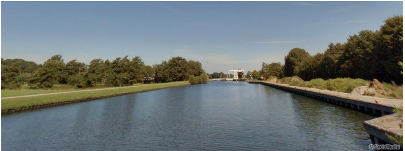
Laad en loskade met op achtergrond de brug N386
