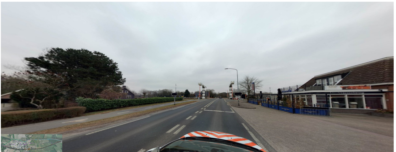
Bestaande situatie aansluiting N386 - Watermolendijk zonder oversteekvoorziening
