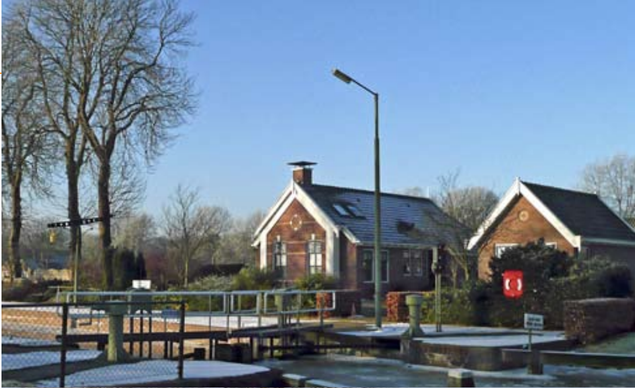
Sluiscomplex bij Geeuwenbrug
