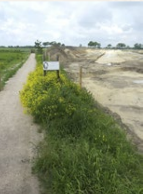
Aanleg gasleiding door de NAM in 2013
