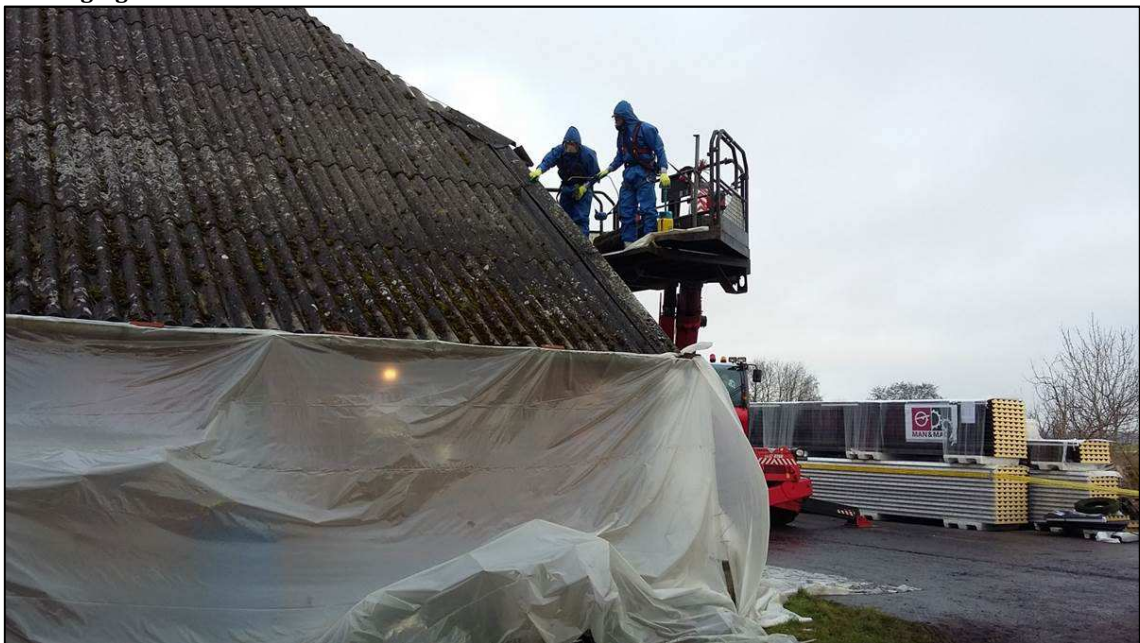
Afbeelding 2.1 Vervanging van een asbestdak in Drenthe
