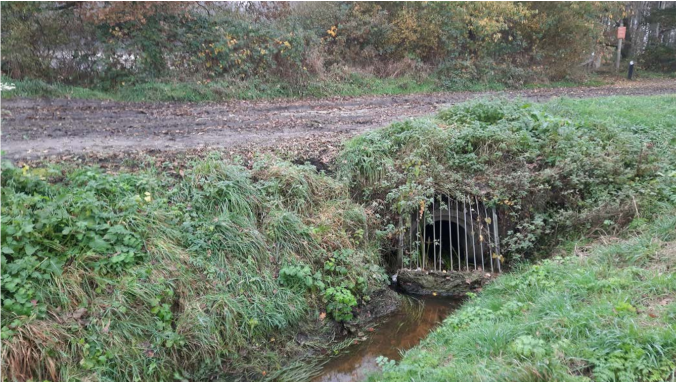
Foto 6.2: De ontwateringssloot langs de zuidkant van het reservaat ligt op minder dan 3 meter van de grens van het reservaat. Een nog diepere ontwateringssloot langs de oostkant van het reservaat ligt op 10 meter van het reservaat en loost zijn water op een ondergrondse leiding die uitmondt midden in het reservaat ('de kom').
