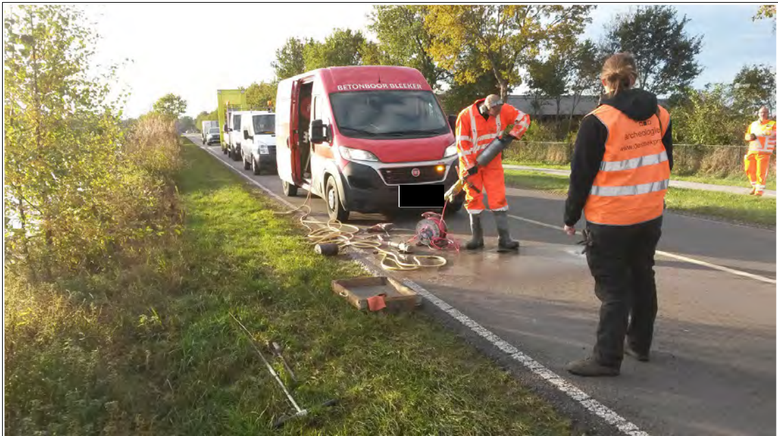
Figuur 2: Norgervaart, N373: op de foto wordt ten behoeve van boring 5 een gat in de weg gemaakt. Omdat niet door de verharding heen geboord kon worden, was het nodig om de boringen in de berm te doen.
