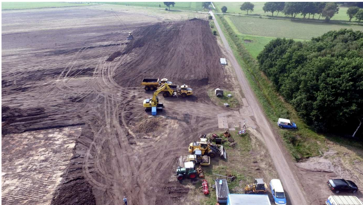
Figuur 17 Werkzaamheden in het Anserveld
