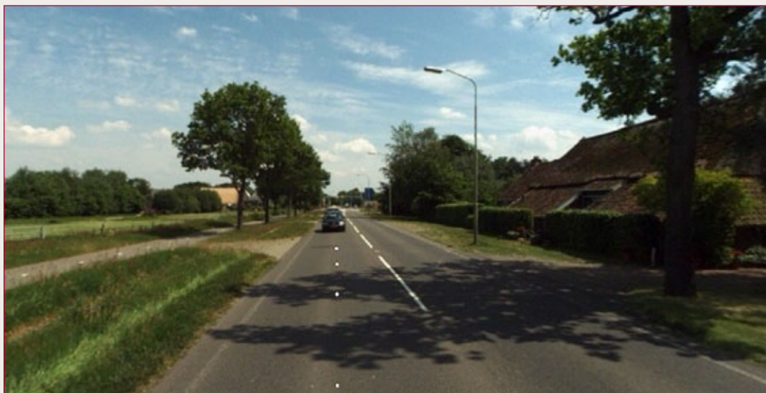
Figuur 5.2 N372 tussen de Driebergendijk en de N386
